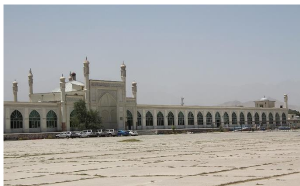
نمای شرقی مسجد جامع عید گاه و صحن وسیع آن
