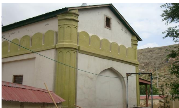
نمای گوشه جنوب غربی آرامگاه
