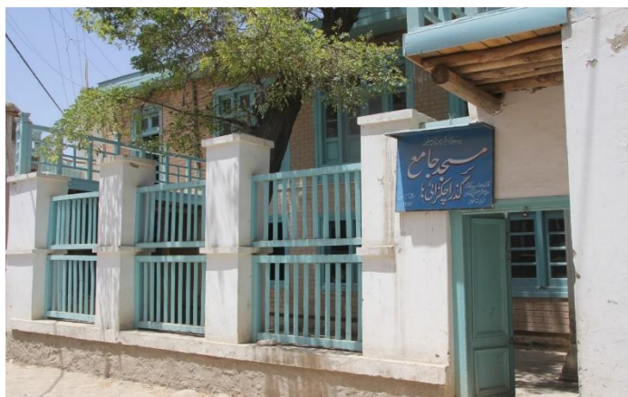
نمای بیرونی مسجد شریف اچکزایی ها
