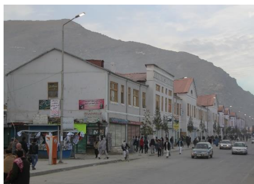
نمای بیرونی عمارات دئ منزله در ساحه باغبان کوچه
